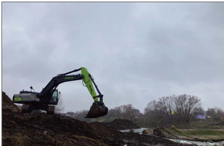
Рис. 1. Возведение земляной защитной дамбы
