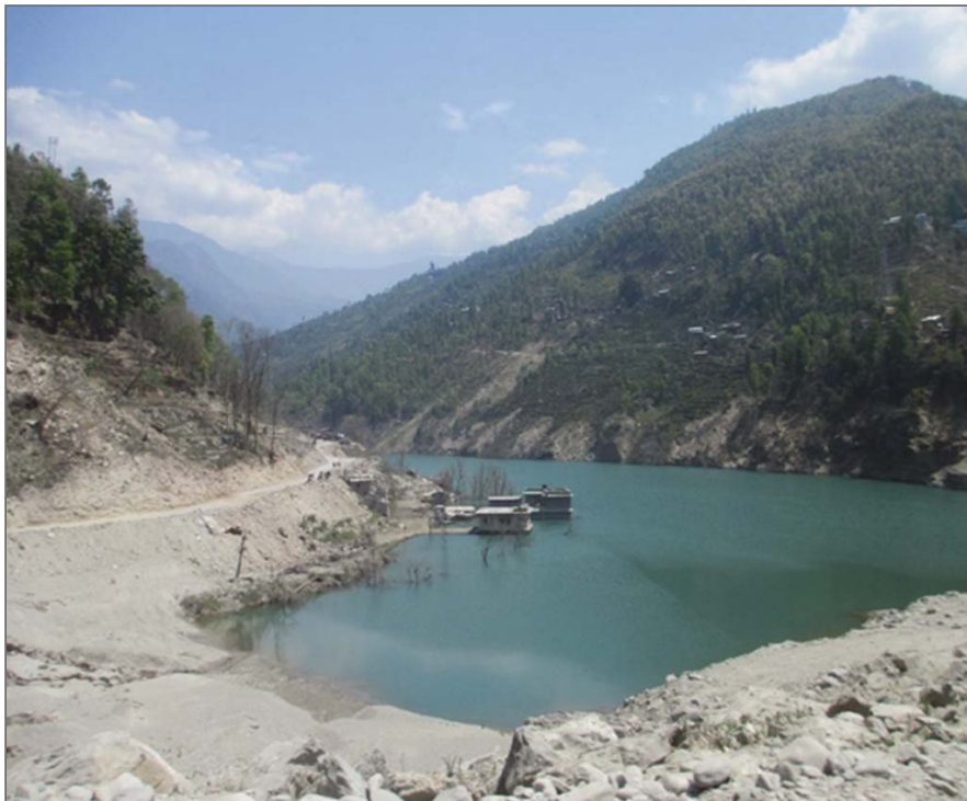
Рис. 2. Завальное озеро в 60 км к северо-востоку от Катманду (Непал). Образовалось 2 августа 2015 года в результате перекрытия долины реки Санкоши грандиозным оползнем объемом около 50 млн м 3 (фото С.Г. Миронюка, 2016 г.)
