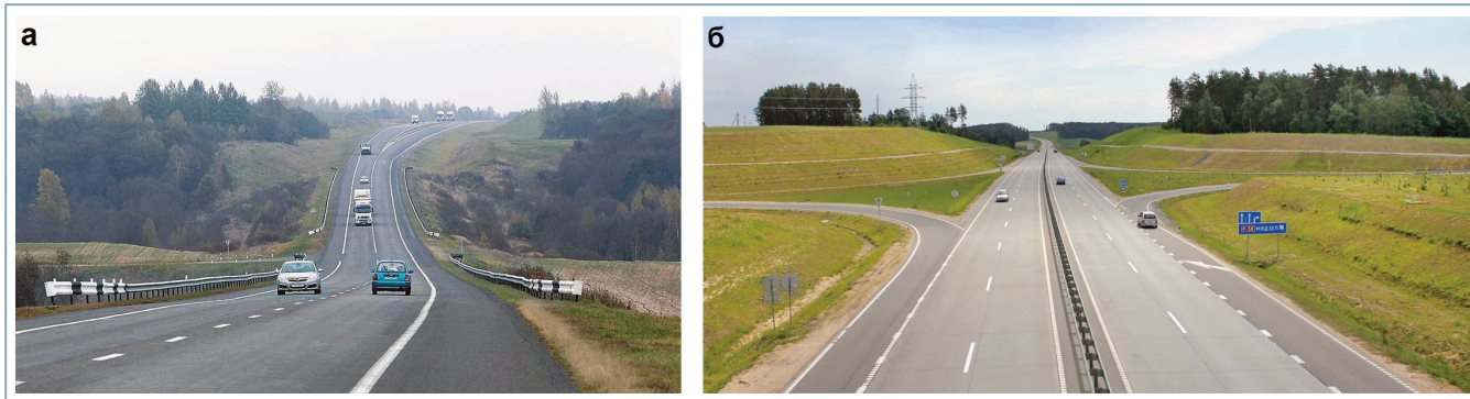
Рис. 4. Автомобильная трасса Витебск – Полоцк с асфальтобетонным покрытием (а) и Вторая минская кольцевая автомобильная дорога с цементобетонным покрытием (б) [21]
