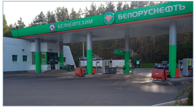
Рис. 5. Автозаправочная станция на трассе М-3 в Логойском районе Минской области [19]
