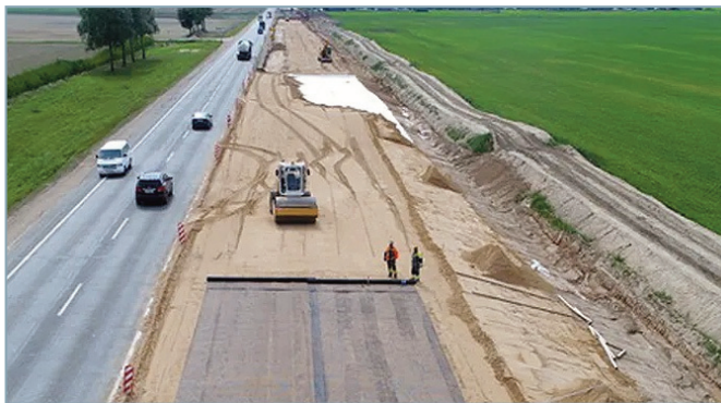
Рис. 6. Реконструкция республиканской автомобильной дороги Р23 Минск – Микашевичи с применением геосинтетических материалов [25]
