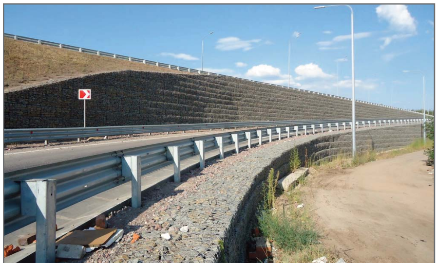
Рис. 2. Армированное сооружение каскадного типа на основе системы «Террамеш» на обходе г. Воронежа на 507 километре трассы М4 «Дон»
