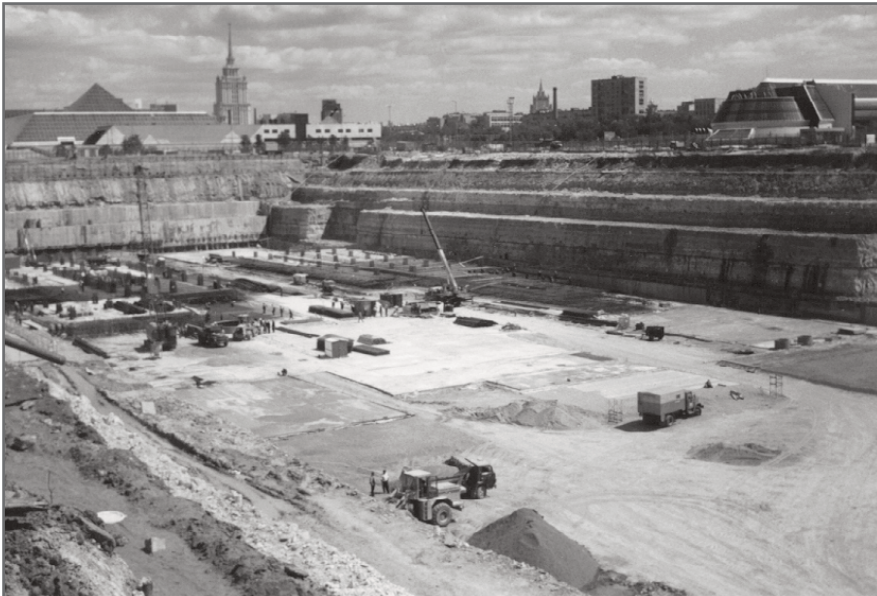
Рис. 4. Общий вид котлована для строительства «Центрального ядра» ММДЦ «Москва-Сити» в 1999 году [19]
