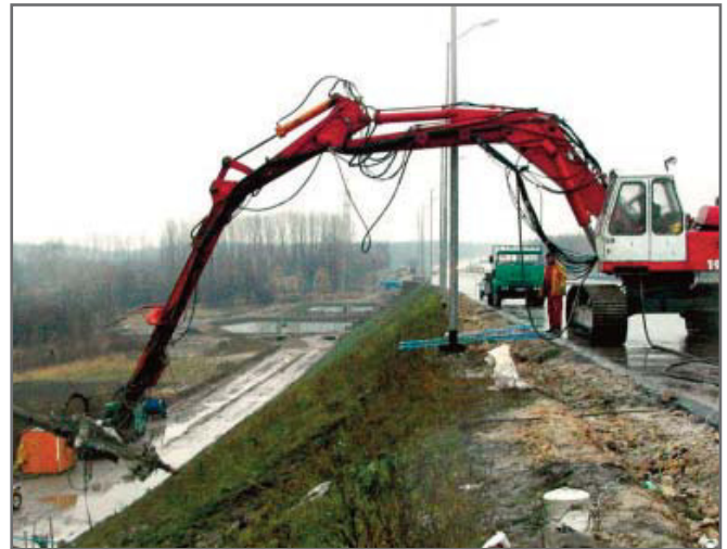
Рис. 10. Использование навесной буровой мачты на обычной строительной технике для бурения с помощью буроинъекционных штанг малых и средних типоразмеров (с внутренними/наружными диаметрами от 30/16 до 52/26) [8]
