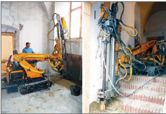
Рис. 11. Применение малогабаритных буровых установок для укрепления фундаментов существующих зданий и сооружений (в том числе исторических) как изнутри, так и снаружи [8]
