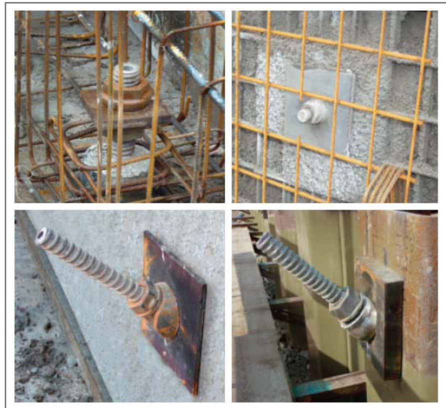
Рис. 7. Варианты головных конструкций [8]
