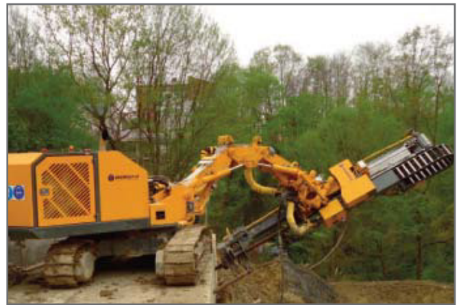
Рис. 12. Использование самоходной буровой установки для бурения с помощью буроинъекционных штанг всех типоразмеров (с внутренними/наружными диаметрами от 30/16 до 103/43) [8]
