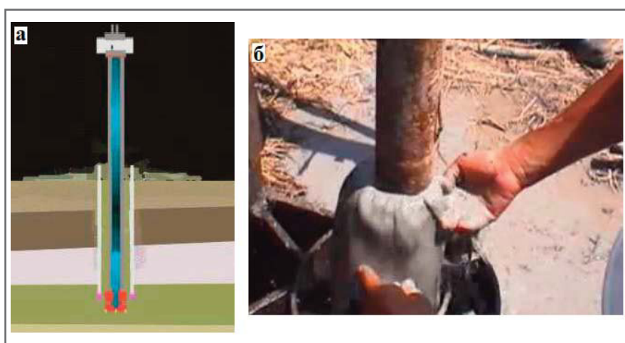
Рис. 2. Метод вращательного роторного бурения (а) и суспензия, поднимающаяся из скважины (б)
