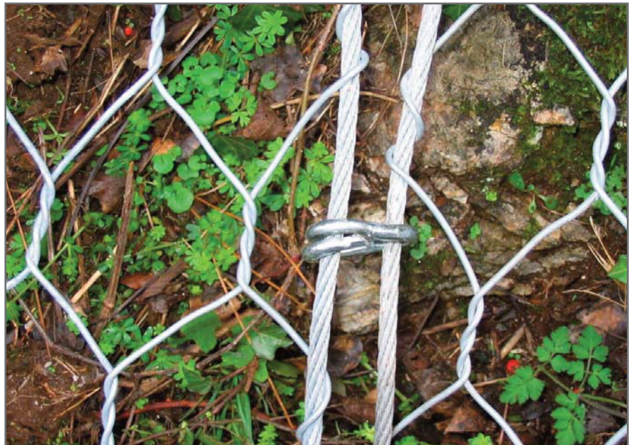
Рис. 1. В системе «Стилгريد®» тросы интегрированы в скрутки сетки
