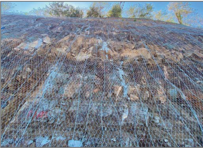
Рис. 6. В случае этой подделки тросы просто наложены сверху на сетку и закреплены сверху анкерами
