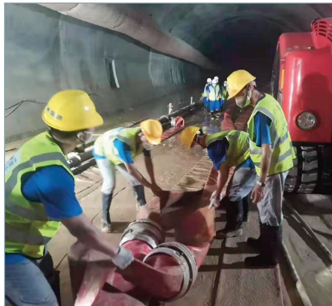
Рис. 3. Спасатели раскладывают дренажное оборудование (источник фото: https://www.guancha.cn/politics/2021_07_17_598831_s.shtml )
