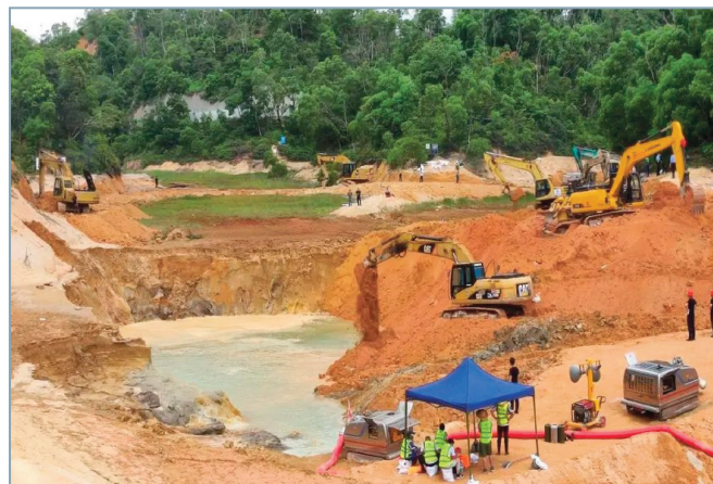
Рис. 4. Участок проведения спасательных работ (источник фото: https://www.guancha.cn/politics/2021_07_17_598831_s.shtml )
