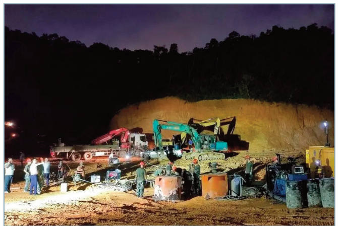
Рис. 6. Система мониторинга и управления аварийно-спасательными работами (справа) (источник фото: https://www.guancha.cn/politics/2021_07_17_598831_s.shtml )
